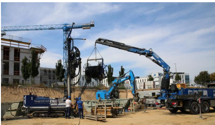
Oberflächennahe Geothermiebohrung am Mainzer Kisselberg
