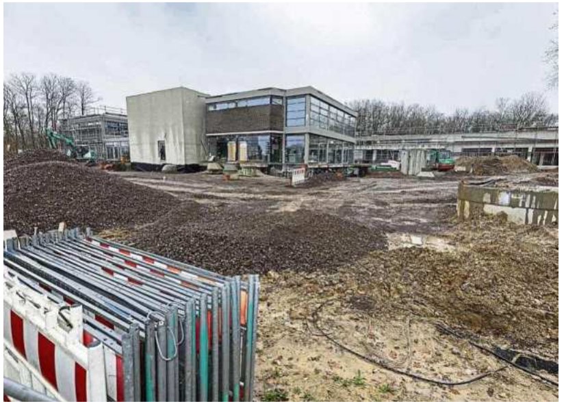
Die Baustelle für das Bürgerhaus im Stadtteil Lerchenberg: Nun gibt es eine Unterschriftensammlung für ein Komplettprogramm in Sachen Gastronomie.
