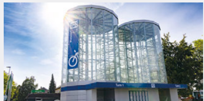
Die Zwillingbikesafes am Bahnhof in Hannover-Wunstorf schaffen Parkraum für 244 Stellplätze auf jeweils 12 Metern Höhe – platzsparend & komfortabel
