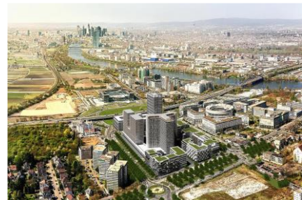
Abbildung 2: Neubaquartier mit Hochhäusern
