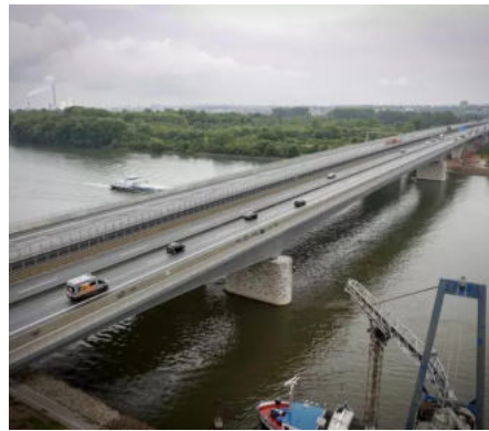
Die Schiersteiner Brücke im Januar 2014. © Sascha Kopp
