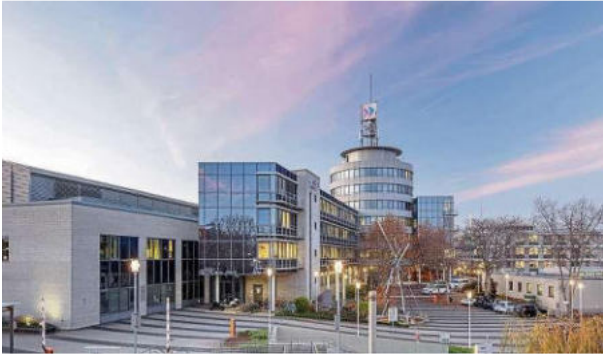
Welche Bedeutung wird das Mainzer Sendezentrum für den SWR in Zukunft noch haben? Mit mehrjähriger Verzögerung soll zwar ein neues „Aktualitätshaus“ gebaut werden, Investitionen in die klassische Studiotechnik wurden in Mainz aber vernachlässigt.
